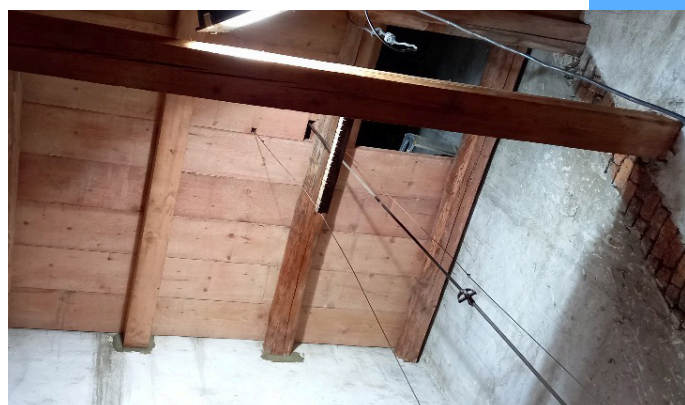
◀ ▼ Nowe elementy konstrukcyjne schodów
